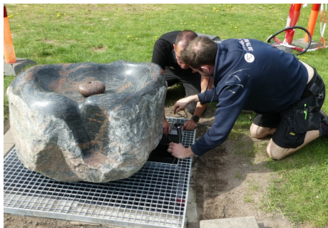
Springvandsstenen er bragt på plads, og der slutes strøm til pumpen.
