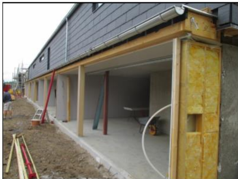
Underetagen udbygges med karnap, og gulvene i stueetagen gøres klar til den nye belægning af træ eller klinker.
