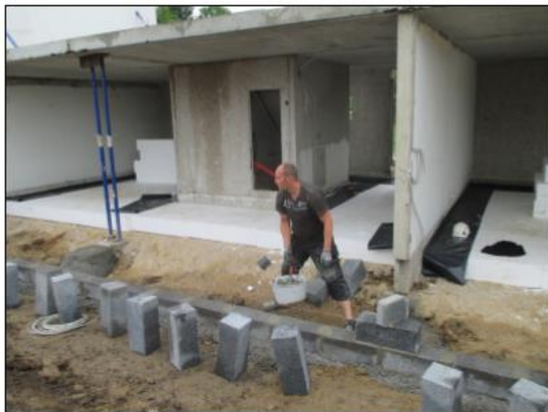
Krybekældrene ryddes, der støbes fast underlag, og der etableres sokler for de nye karnapper.
