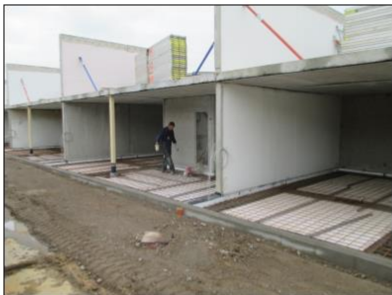
Gulvene isoleres med et tykt lag flamingo, og der indlægges gulvvarme.
