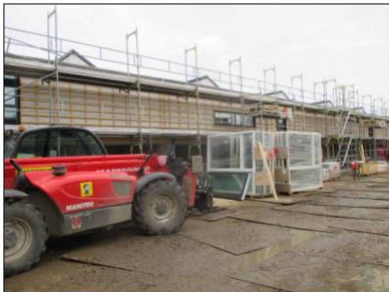
På overetagerne monteres nye facadeelementer.
